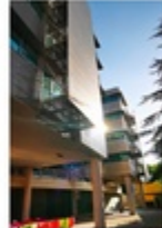
Les escaliers de secours
