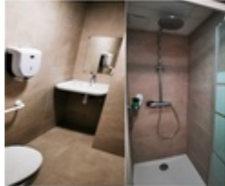
Douche et sanitaire rez-de-chaussée Cédille
